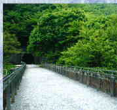
めがね橋上から6号トンネル
