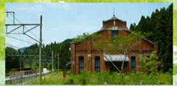
明治44年建造の変電所は国の重要文化財です
