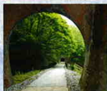
7号トンネルから6号トンネル
